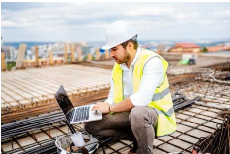
콘크리트 내부 결함 모니터링 시스템
